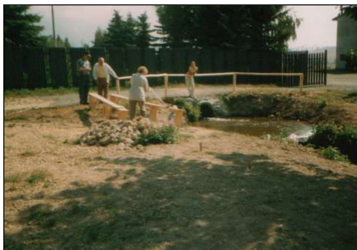
Rozšírenie koryta potoka Jamníček, ktorý by mal v budúcnosti slúžiť v rámci areálu ako priestor na kúpanie
